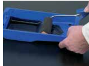
Voorbehandeling houten draagconstructie met Primer SX Black
