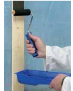
Voorbehandeling houten draagconstructie met Primer SX Black
