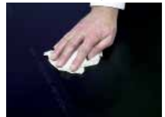
Voorbehandeling achterzijde steni met Easy Clean Wipes
